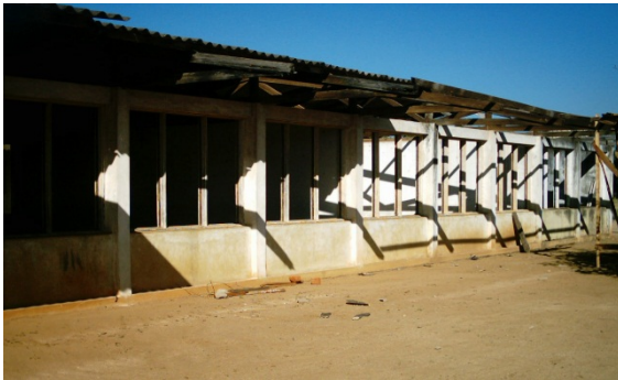
Instalações antes das obras de recuperação da infra-estrutura
