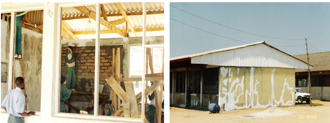
Obras de requalificação da infra-estrutura
